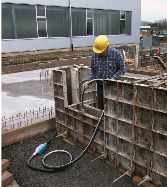
Abb. 1 Betonverdichtung mit einem Innenvibrator
